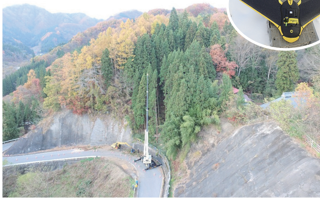
クレーンによる搬出間伐状況（ドローン撮影画像）
