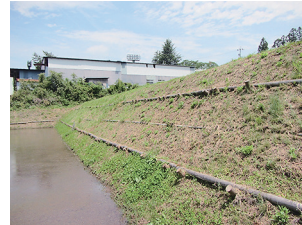
畦畔に施工された足場
