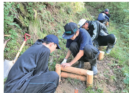
階段修理作業の様子
