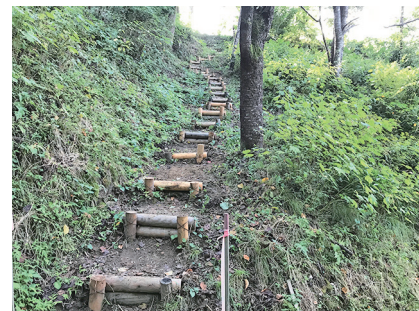
完成した階段
