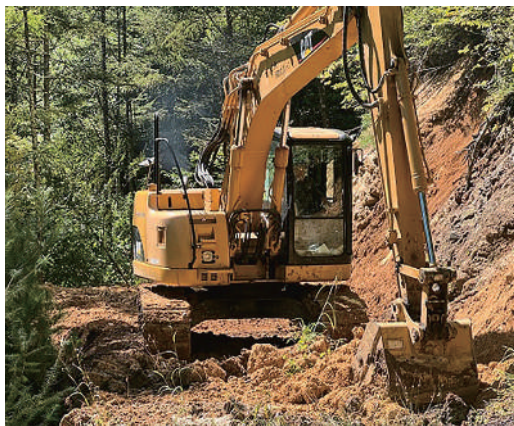
既設作業道補修工作業中
